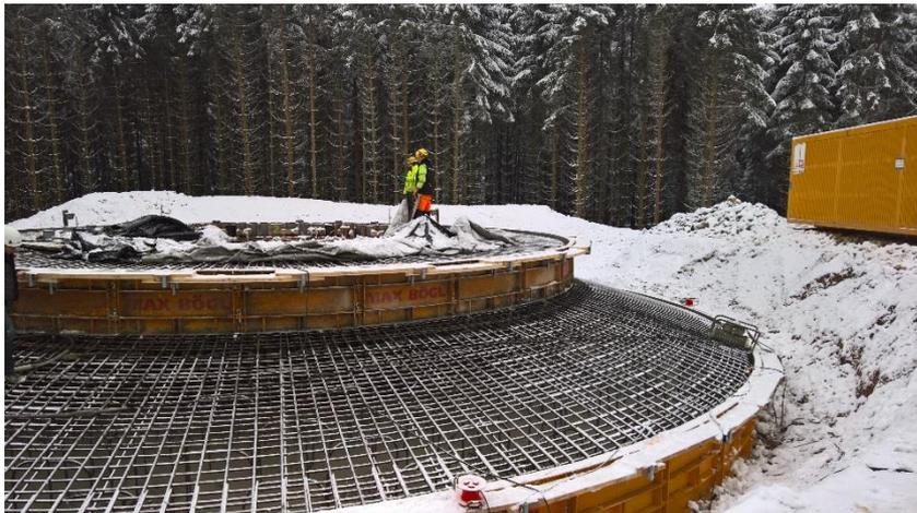
Für ein Fundament werden über 500 Kubikmeter Beton benötigt. Eine Fundamentplatte wird von bis zu 30 Pfählen mit einer Tiefe von jeweils etwa 20 Metern gestützt.
