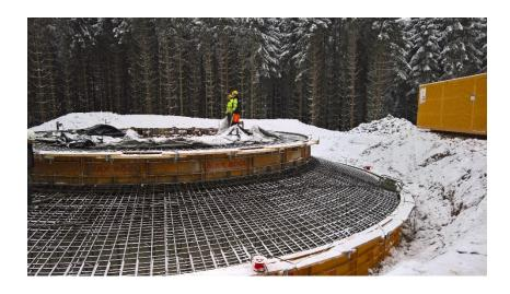
Für ein Fundament werden über 500 Kubikmeter Beton benötigt. Eine Fundamentplatte wird von bis zu 30 Pfählen mit einer Tiefe von jeweils etwa 20 Metern gestützt.
